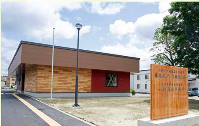
外壁(トドマツ・エゾマツ・カラマツの下見板張り)
