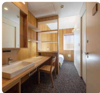
社有林材を活用したCLTを用い建設した研修施設
