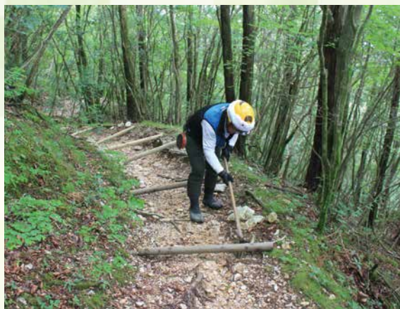
工石山 グリーンサポートスタッフによる歩道修理
