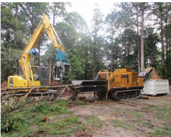
木材破砕機による破砕作業
