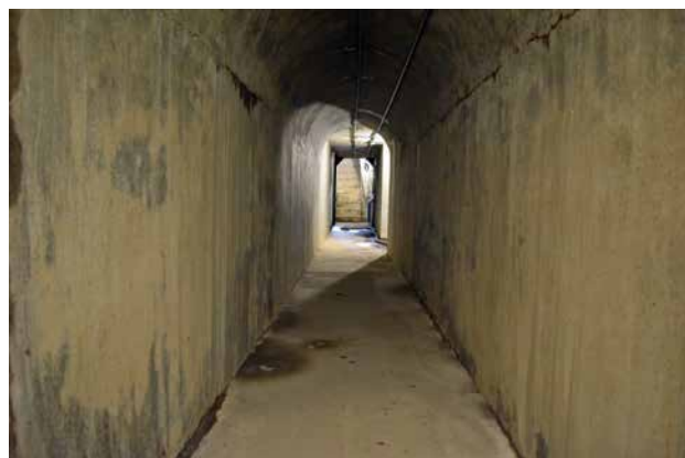
竹筋コンクリート製の地下道
