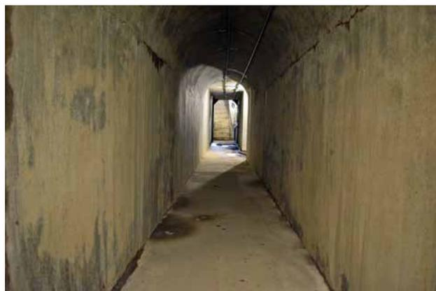
竹筋コンクリート製の地下道
