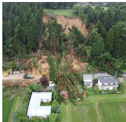
令和5年7月梅雨前線豪雨災害による被害(秋田県秋田市)
