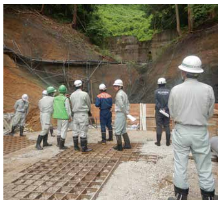
消防・警察と連携した治山施設パトロール
