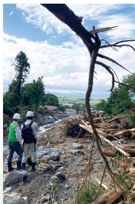
職員派遣による災害箇所調査
