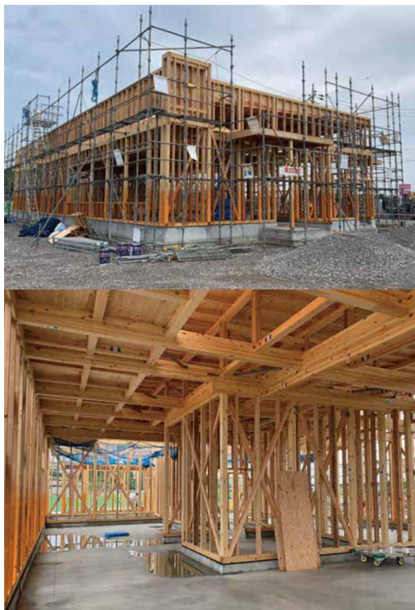
施工中の木造店舗(茨城県、51号潮来店)
