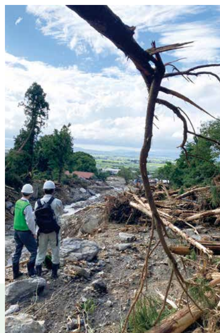
職員派遣による災害箇所調査
