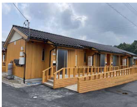
木造応急仮設住宅(長屋型)
