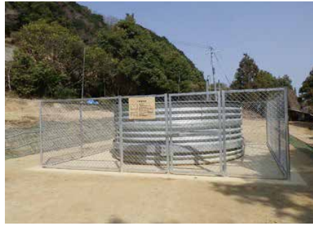
完成した集水井
