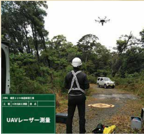
UAVレーザにより起工測量し、省力化を実現
