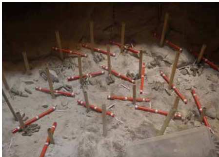
低振動かつ瞬時に破砕可能な非火薬岩石破砕工により労働者の安全を確保
