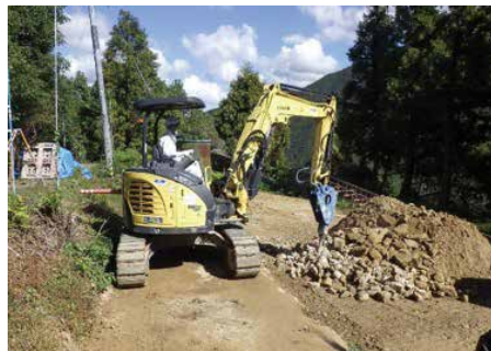
掘削した土石を混合し空隙を少なくすることで現地発生土の運搬回数を軽減
