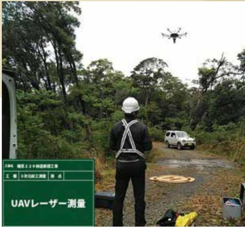
UAVレーザにより起工測量し、省力化を実現
