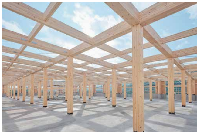
施工中の木造店舗
