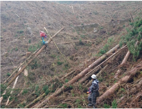
荷掛けの機械化
