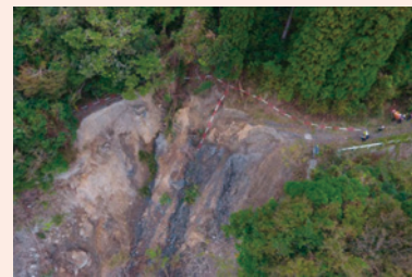
ドローンを活用した被災状況調査
