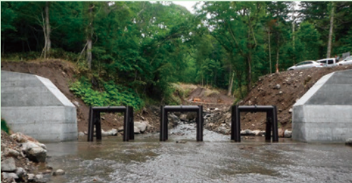
流木捕捉式治山ダム工
