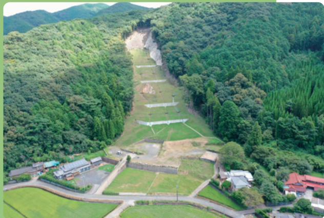
写真5 完成状況 (芦北町岩本地区)
