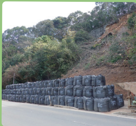
写真2 大型土のうの設置 (芦北町椈谷地区)
