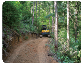
森林作業道の整備
