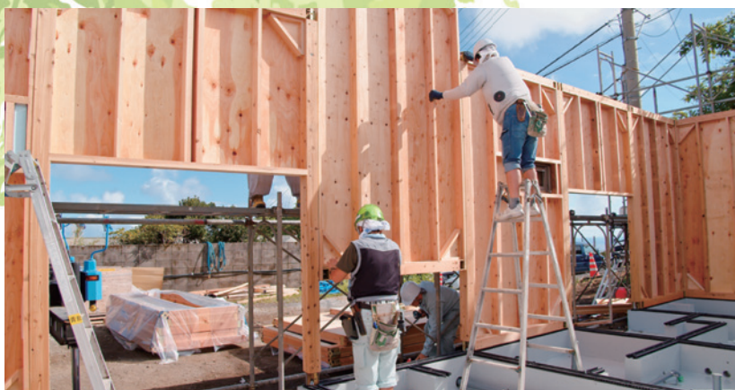
外壁パネルの施工
