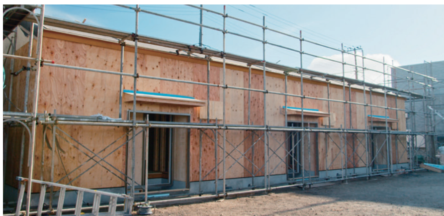
「在来軸組パネル構法」の外観
