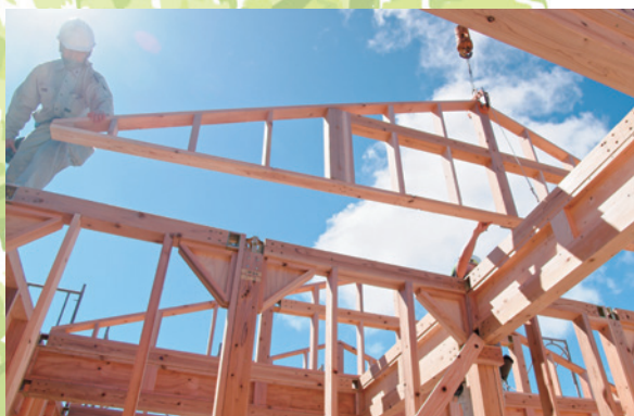
小屋組パネルの施工
