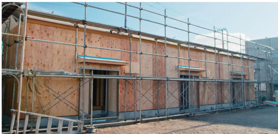
「在来軸組パネル構法」の外観
