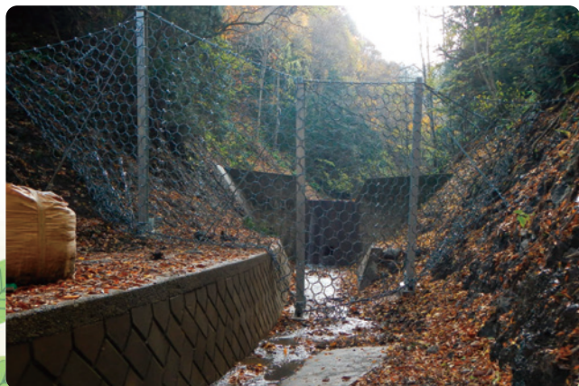
写真6：設置したワイヤーネット工
