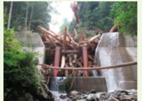
流木捕捉式治山ダムの整備
