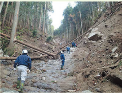
令和元年東日本台風 (溪流の縦侵食2~3m)
