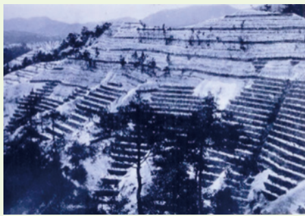
山腹工の施工 (大正6 (1917) 年)
