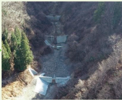
小規模な治山ダムを階段状に配置
