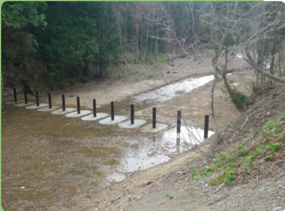
写真5：独立基礎型流木捕捉工
