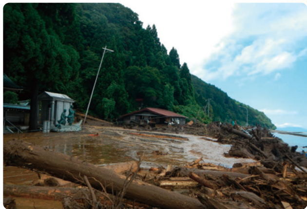
写真1：土砂と流木の被害
