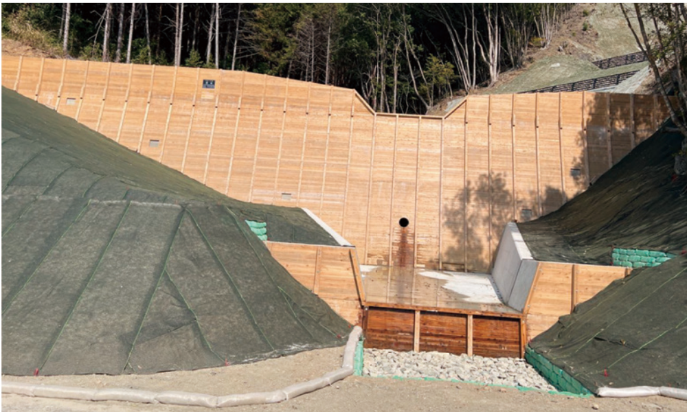
残置式木製型枠
