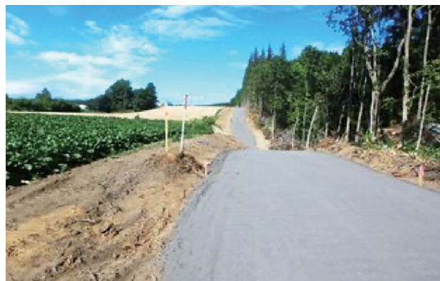
写真3 完成した管理用道路
