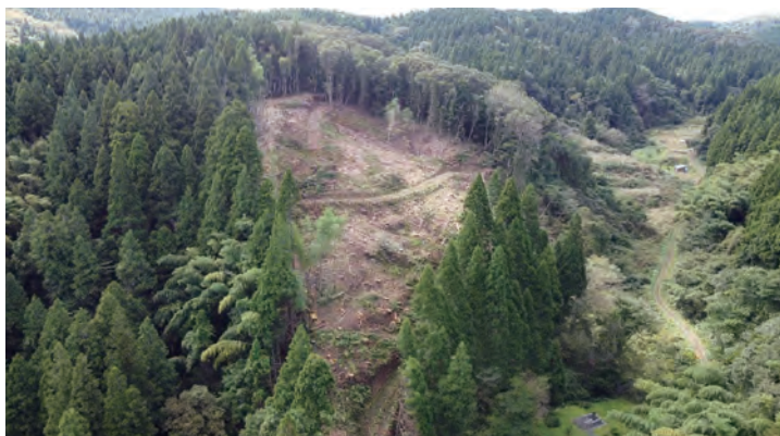
主伐実施箇所（石川県輪島市内）
