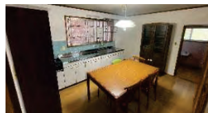
改修後の状況
