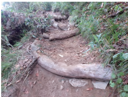
写真6 近自然工法による施工箇所
