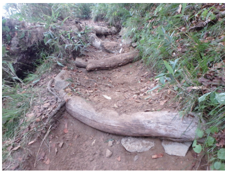
写真6 近自然工法による施工箇所
