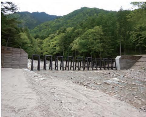
写真1 流木捕捉式治山ダムの設置
