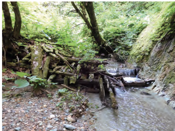
写真3 2号堰堤 (大正5年竣工)
