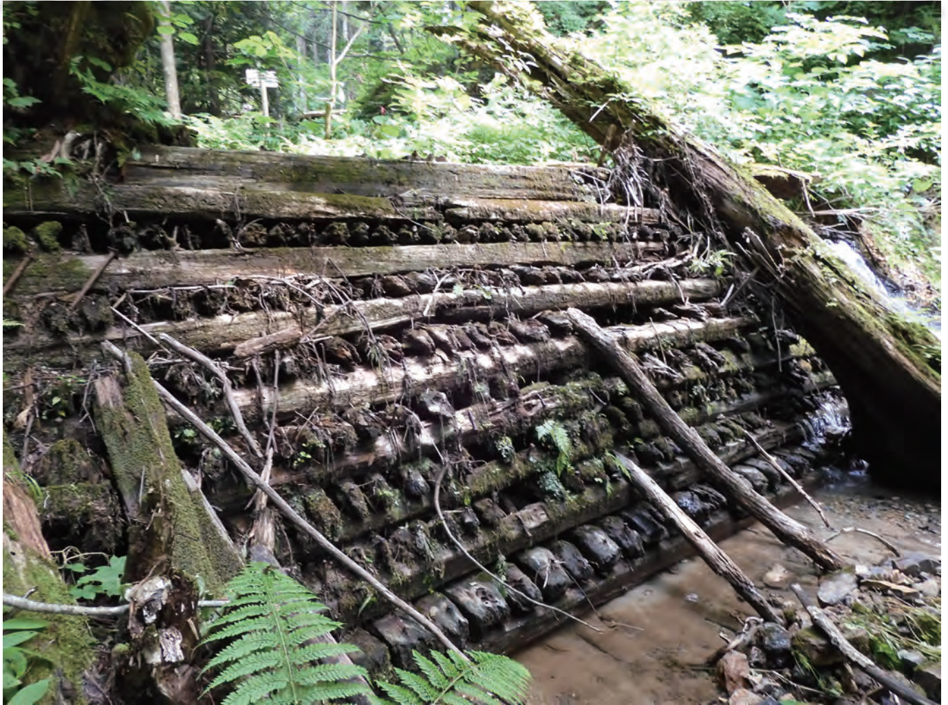
写真1 4号堰堤(昭和29年竣工)
