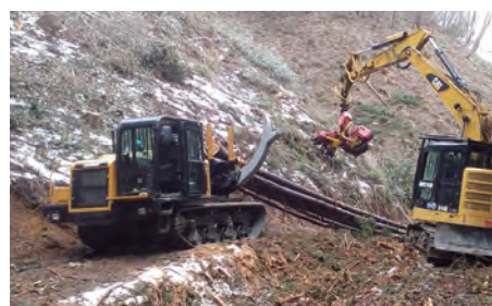
・ベース車の荷台を、クランバンプ仕様に改良 ・自動走行とラジコン操作を組み合わせた無人集材作業に成功 (令和3年度)
