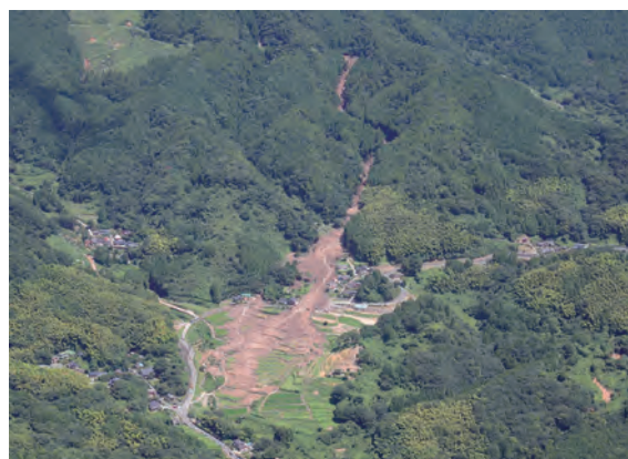
令和3年8月豪雨災害による住宅等被害(佐賀県神埼市)
