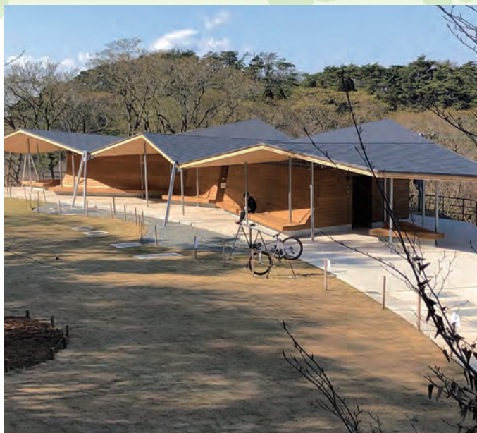
▲ 内装材に木材を使用した公共建築物（六甲最高峰トイレ）
