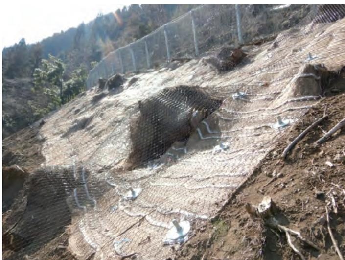
高強度ネットによる斜面の安定対策
