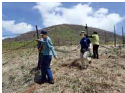
5月 三国山シカ防護柵を設置
