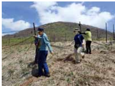
5月 三国山シカ防護柵を設置
