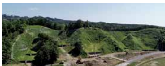
写真7 復旧された様子
