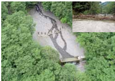
写真 14 既存治山ダムの上流部に流木の捕捉機能を追加する取組（中部森林管理局）
