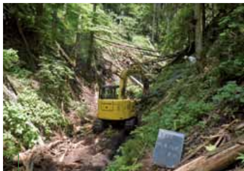
写真 15 溪流沿いの危険木の除去（群馬県）
