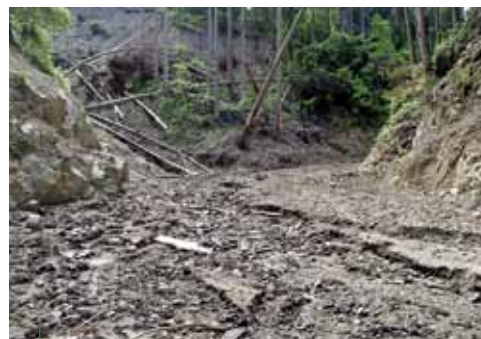
写真1 被災直後の様子（福岡県朝倉市）
