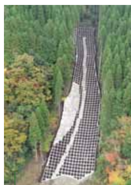
写真11 復旧された様子
