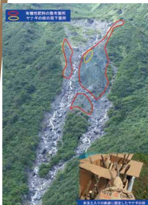
写真2 緑化工の施工箇所
