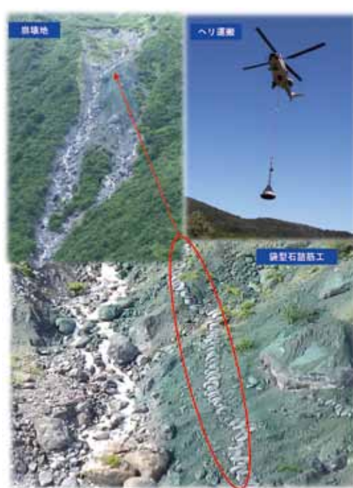
写真1 袋型石詰筋工の施工状況
