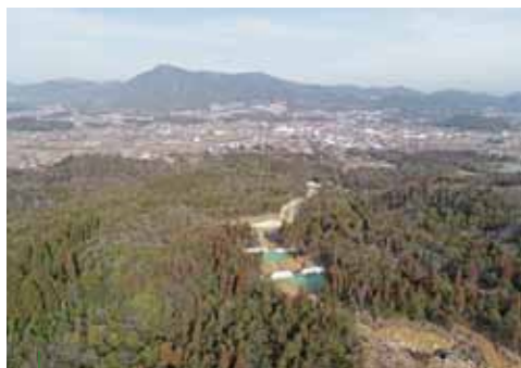
写真3 土石流対策のための治山ダムの設置（広島県東広島市）
