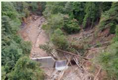
治山ダムが土砂や流木を捕捉（青森県風間浦村、令和3年8月大雨）
