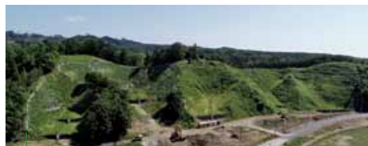
写真7 復旧された様子
