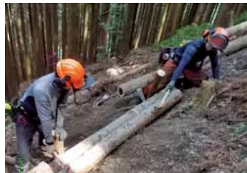
写真 13 筋工の設置の様子（静岡県）
