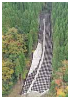
写真11 復旧された様子
