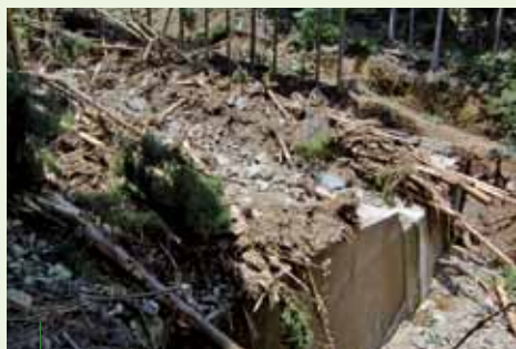
治山ダムが土砂や流木を捕捉（鹿児島県さつま町、令和3年7月大雨）
