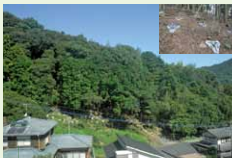
森林斜面の崩壊を防止（長崎県長与町、令和3年8月大雨）
