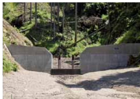
写真2 流木捕捉式治山ダム
