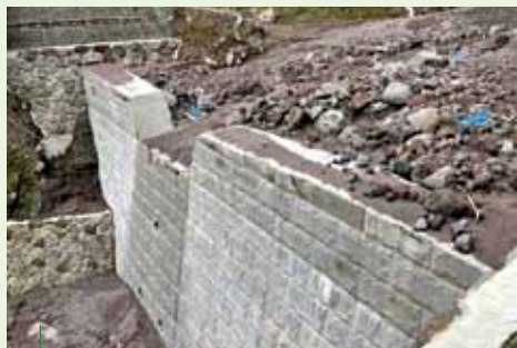
治山ダムが土石流の流下エネルギーを軽減（大分県別府市、令和3年8月大雨）
