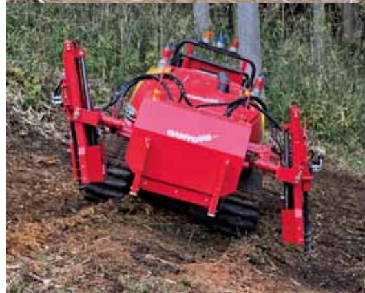
写真7、8 林地残材を集積し、作業の支障となる伐根を処理
