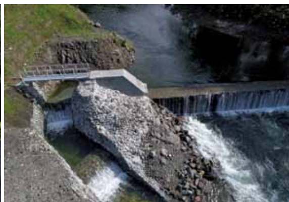
写真4-2 岩盤を掘削して設置した魚道
