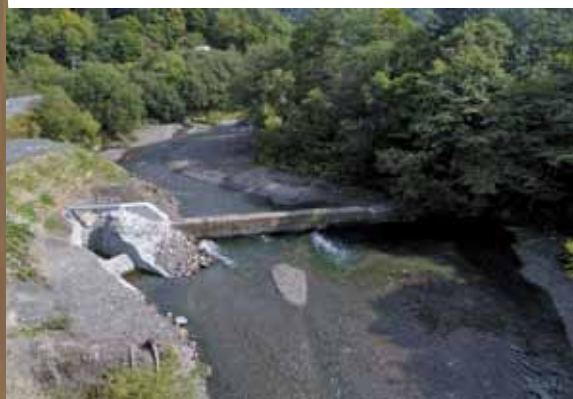
写真4-1 改良工事完成後
