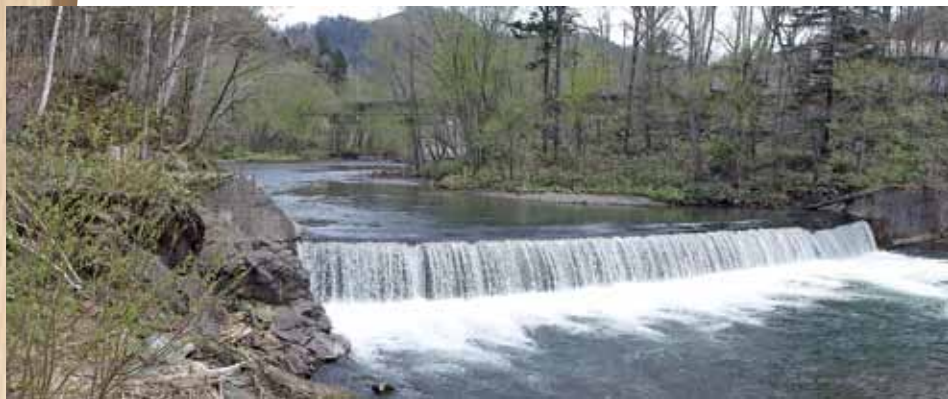
写真1 落差工によるコンクリート堰堤
