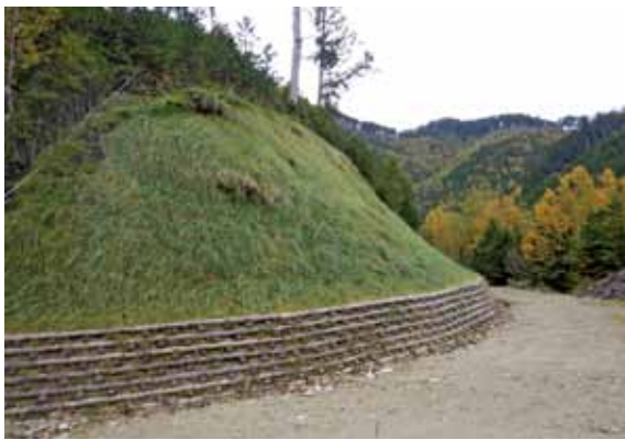
写真1 法面保護工を行った氷ヶ瀬小俣林道
