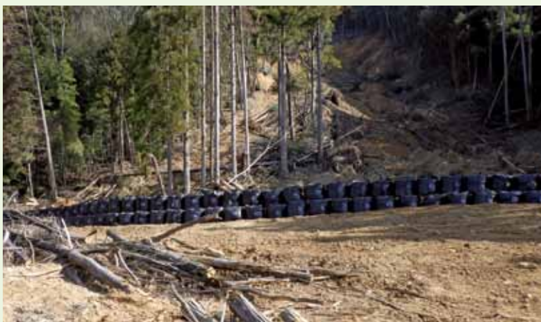
写真3 熊本県芦北町の応急対策完成の様子
