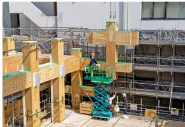
十字ユニットを順に積み上げる。巨大だが、他資材よりも軽く、施工性は容易という
