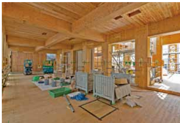
完成時は被覆される床、壁、天井も、建設時はこのとおりの木質感
