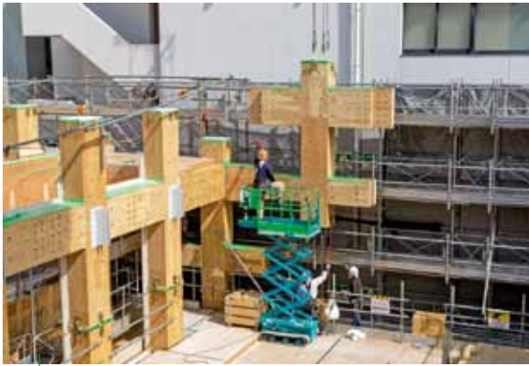
十字ユニットを順に積み上げる。巨大だが、他資材よりも軽く、施工性は容易という
