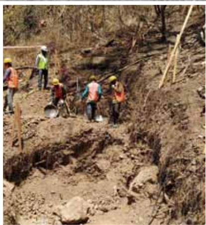
2 床掘工事業業
