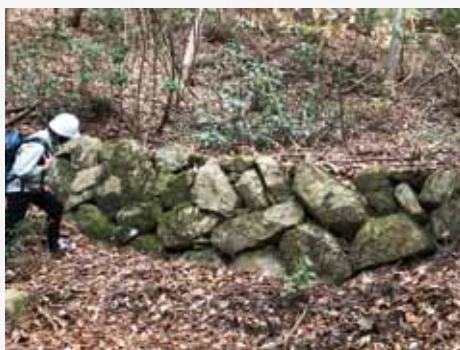
写真6 現地に残る石積み
