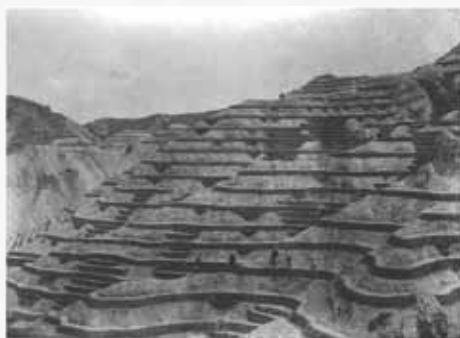
写真2 兵庫県の砂防工事の状況(明治36年) 神戸市森林整備事務所提供
