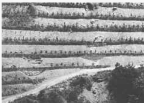
写真5 石積みや積苗工、苗木の詳細が確認できる
