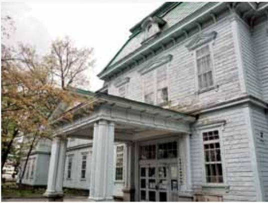
写真1 ヒバ材を用いた建築例
