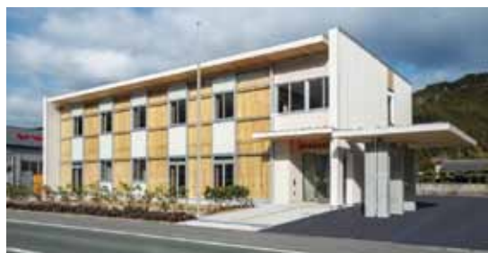
林野庁四国森林管理局 嶺北森林管理署 (木造2階建て庁舎)
