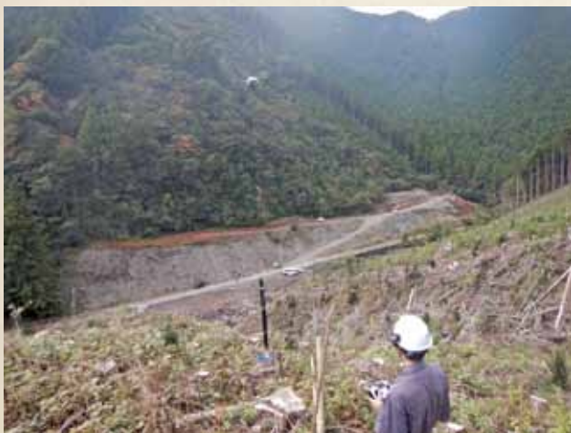
ドローンによる資材の運搬実証の様子
