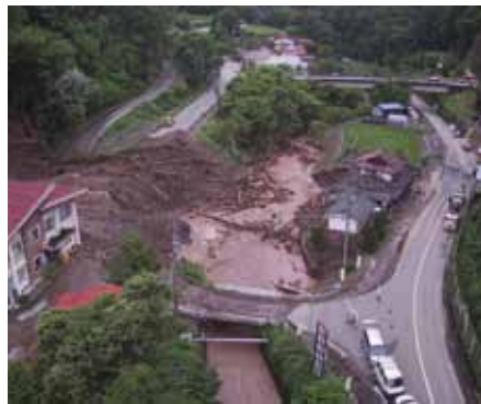
令和2年7月豪雨災害(山腹崩壊)による住宅被害 (岐阜県高山市)
