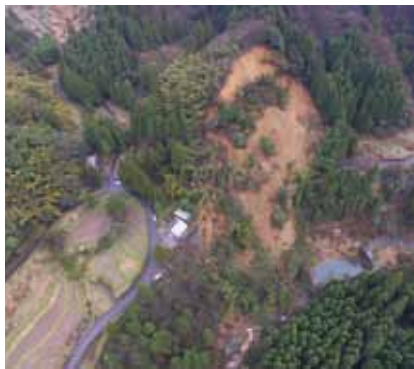
令和2年2月に発生した地すべり災害 (富山県中新川郡立山町)
