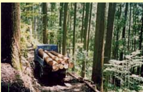
未舗装の作業道で小型のトラックが間伐材を運搬
