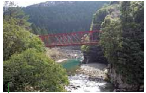
図7 魚梁瀬森林鉄道 明神口橋
